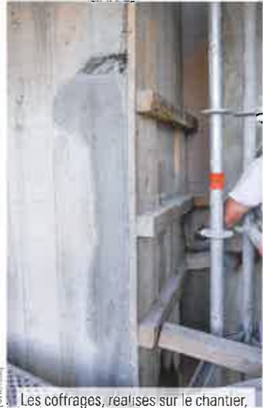
Les coffrages, réalisés sur le chantier, ont pris appui sur l'échafaudage quand c'était nécessaire.
